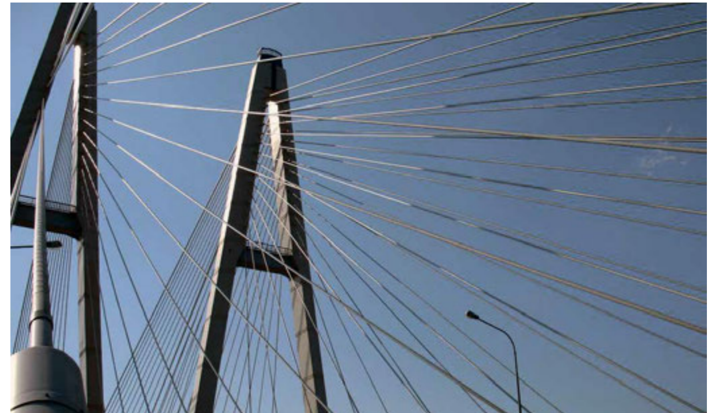
г. Санкт-Петербург, Большой Обуховский мост
